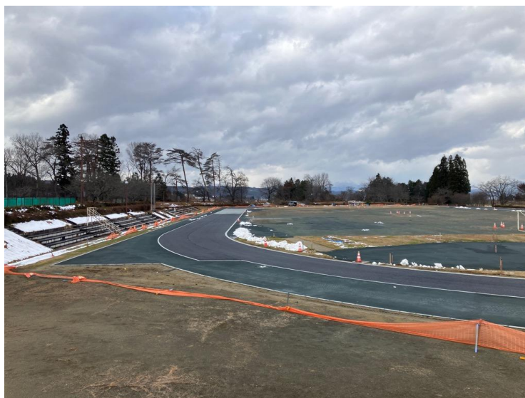
<ふれあいの森公園陸上競技場・改修工事>
