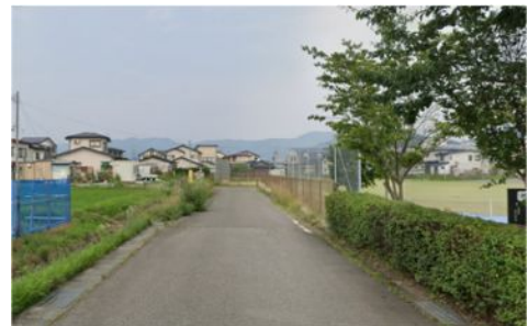
北側法定外道路の現況 西 (町道) 側より
