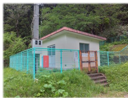
第4水源兼ポンプ場（新鶴地域）
