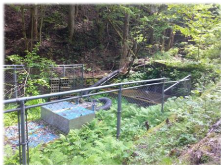
栃沢第2水源（関山地区）
