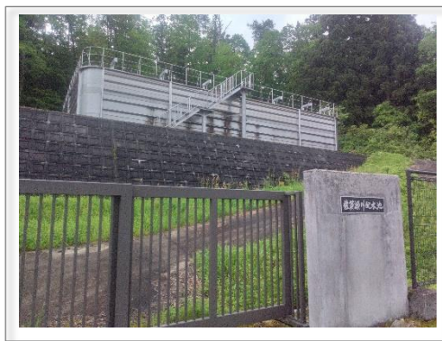
佐賀瀬川配水池
