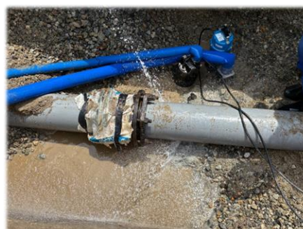
漏水補修時の様子
