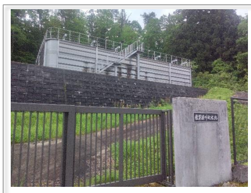
佐賀瀬川配水池
