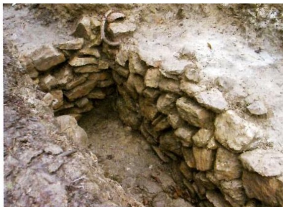
半地下式の倉跡
