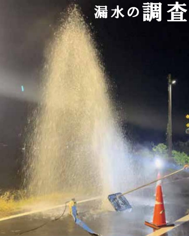
▲大規模漏水により地下から水が勢いよく吹き出す様子
