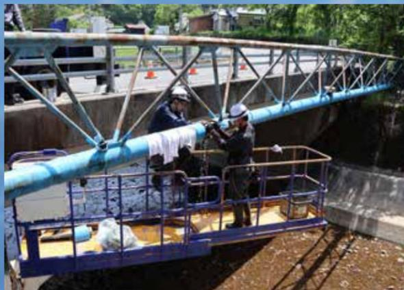
▲老朽化した水管橋の漏水修繕
