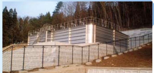
佐賀瀬川配水池完成
