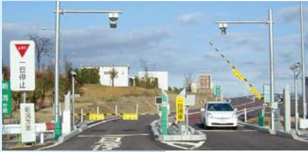
新鶴 P.A スマートインターチェンジ本格導入
