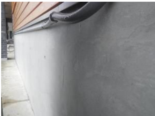
北面外壁 腰壁薄塗材の浮き
