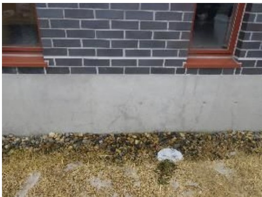
東面外壁 腰壁薄塗材の乾燥収縮によるひび割れ
