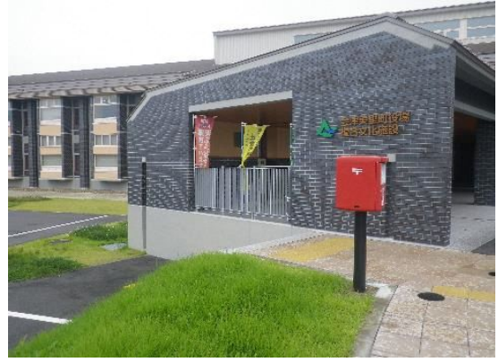
下地補修+再塗装
