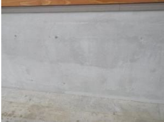
北面外壁 腰壁薄塗材の乾燥収縮によるひび割れ
