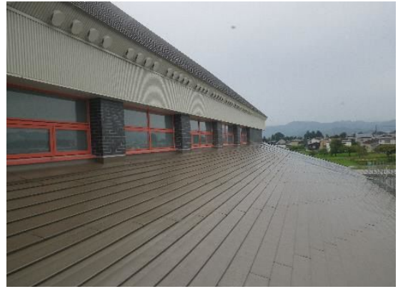
屋根材の撤去及び葺き替え。
