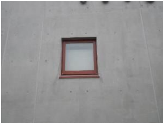
西面外壁 窓開口廻り乾燥収縮によるひび割れ（4ヶ所）
