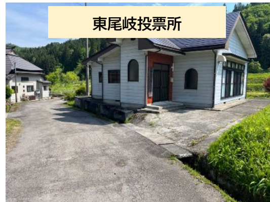
駐車場がない当日投票所
