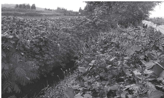
草木が水路を塞ぎ、集中豪雨時にはとても心配だ。
