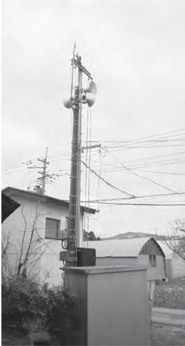
各地区にある防災無線に基地局が設置され、半径 300 m の Wi-Fi 通信が可能
