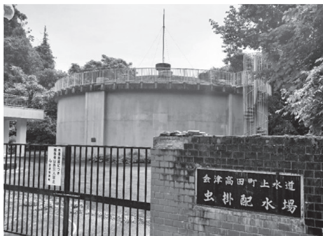
高田地域の拠点配水池（虫掛配水池）
