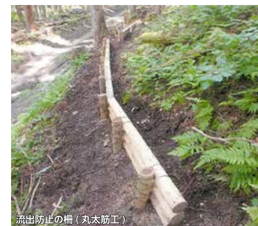
流出防止の柵（丸太筋工）
