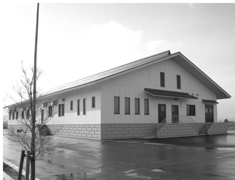
新鶴浄化センター外観
